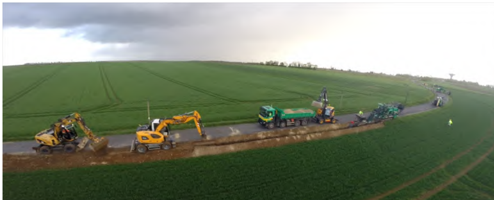
Utilisation de la trancheuse lors de l'enfouissement d'une ligne 20 000 volts, à Saint-Jean-d'Angely. Le terrassement à la trancheuse est réalisé sur une partie du tracé en découpant la chaussée sur 20 centimètres de large et 1,50 mètre de profondeur.
