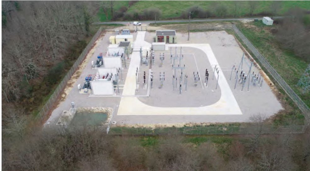
Poste Source après travaux
